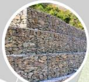
MURO DE CONTENCIÓN Gaviones de alambre de acero
