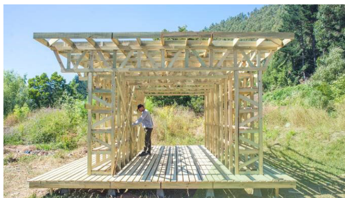
Fig. 3: Etapa final del proceso de montaje de estructuras prefabricadas. Foto: ADAPTO-Chile.
